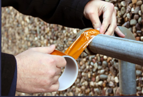
Hidrojen Sızıntı Bandı Uygulaması
